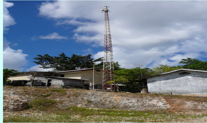
Menara 35 meter untuk pemasangan TeleponRadio Digital
